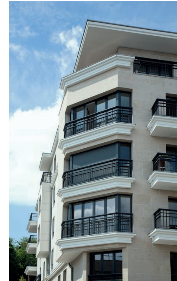
Rue Jacques Decour - SURESNES | 92 Architecte : François de Alexandris
